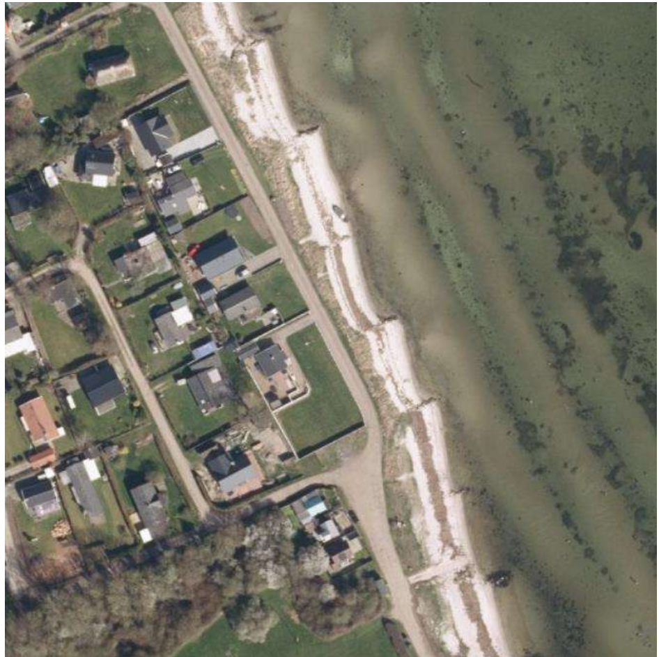
Figur 3.1: Udsnit af den sydlige del af projektstrækningen, hvor der ses læsideerosion ved de eksisterende høfder.
